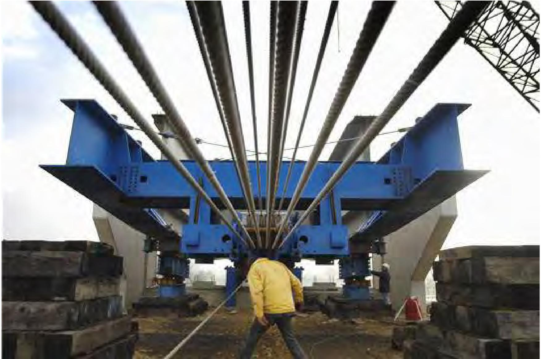
Le viaduc de la Meuse mesure 602,5 m de long. Ici, des câbles soutiennent son tablier (élément horizontal qui comprend la couverture et porte la voie ferrée), soit un poids de 2 100 tonnes d'acier.
